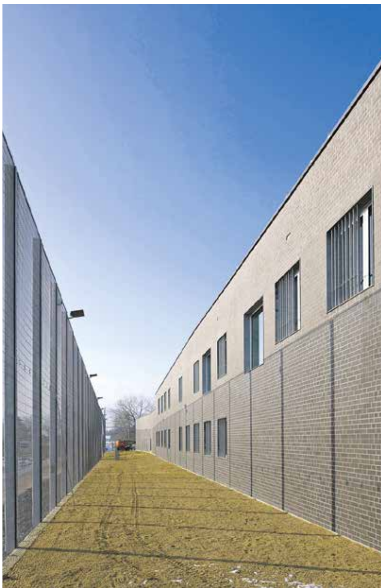
Les coûts de construction de la prison atteignent 30,5 millions de francs.
