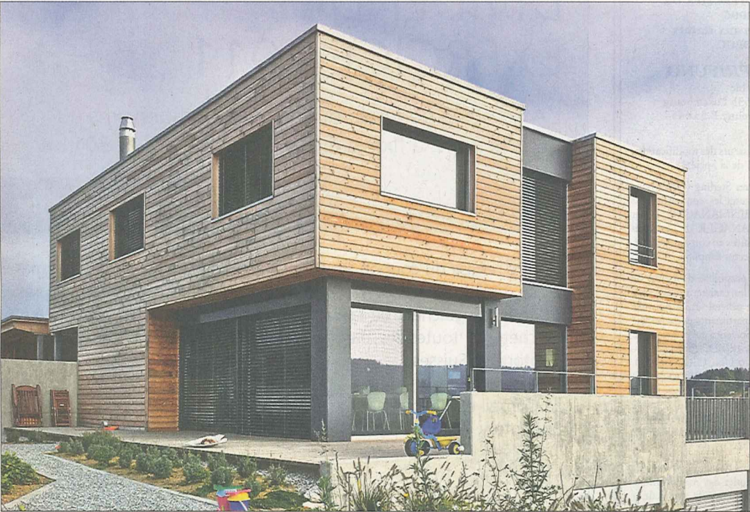
A gauche: maison d'architecte à Porsel (Fribourg) signée aec architectes, J.Rotzer & Partners. A droite: maison sur la Riviera à La Tour-de-Peilz conçue par le bureau nomad architectes, Sion. ARCHIVES
