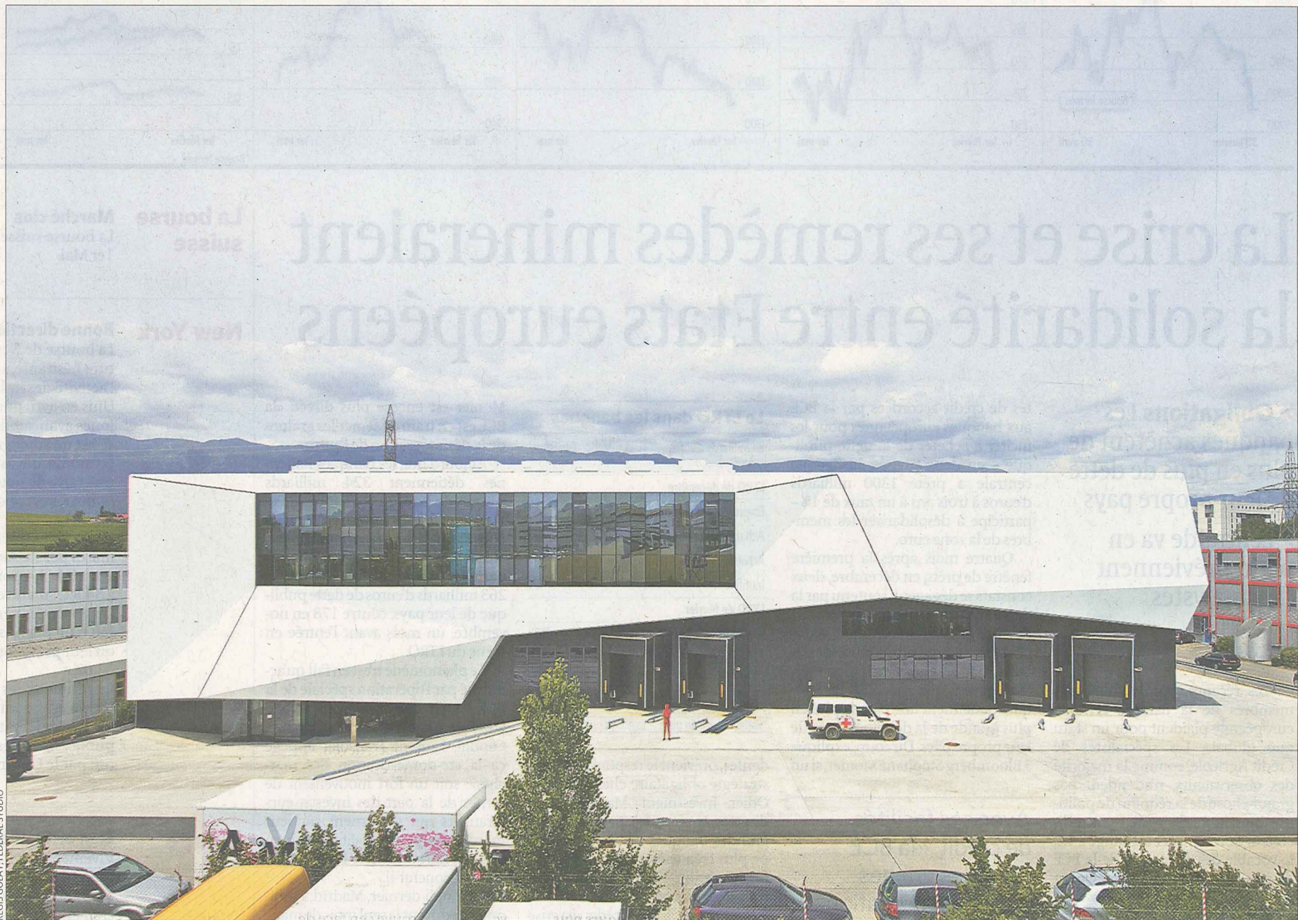
Halle logistique du CICR. Le bâtiment, achevé en 2011, est l'œuvre du bureau genevois group8. ARCHIVES
