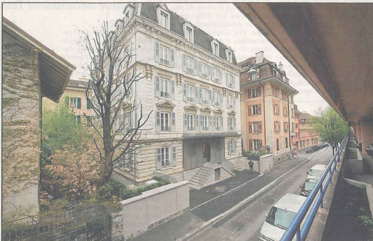
Le nouvel établissement pénitentiaire se situe près de la gare de Lausanne. ARC
