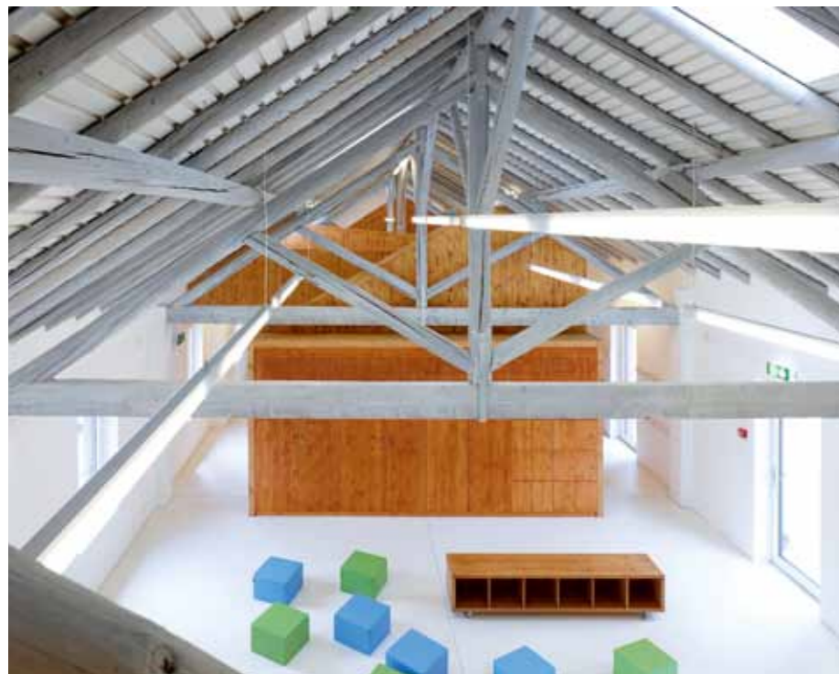
La charpente a été conservée. Elle a été surélevée pour accroître les espaces au moyen d'une mezzanine.
