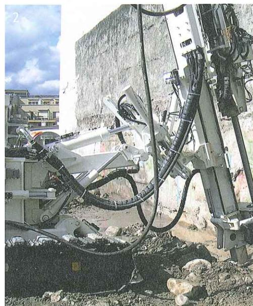
1 et 2. Les ancrages sont installés pour solidifier le bâtiment voisin. La tension peut atteindre 90 tonnes par ancrage.
