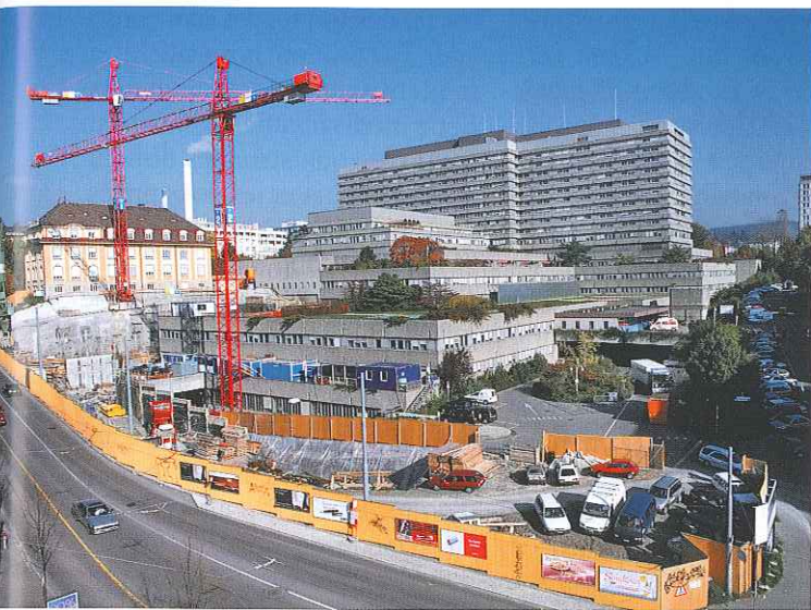
Délimitation du chantier de la PMU, octobre 1999.
