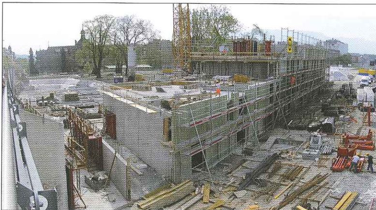
Les façades sont des éléments préfabriqués, hauteur 250 cm, largeurs 120/140/190 cm, constitués de parement extérieur en béton armé 100 mm, surface ondulée selon matrice, teinté vert dans la masse. Isolation PE 150 mm, panneaux porteurs en béton armé de 150 mm, enduit 15 mm.
