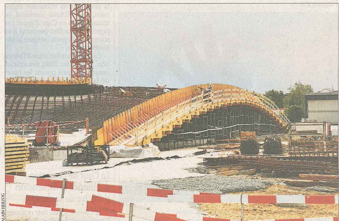
Le chantier. La carcasse de la future vague en béton sort de terre. LAUSANNE, MAI 2008
