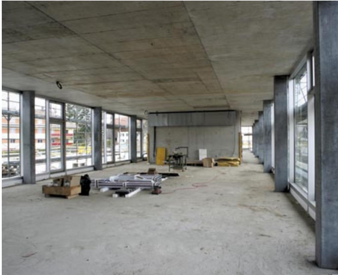
Les éléments porteurs, des piliers préfabriqués en béton armé, sont disposés le long des deux façades longitudinales. La portée de 9 m entre les piliers est constituée de dalles pleines en béton armé d'une épaisseur de 30 cm. La façade est rythmée par une combinaison de portes et d'impôstes garantissant une ventilation naturelle des locaux. Cette façade vitrée de 30 m de long ouvre ainsi la vue sur la future place du village lui conférant une sorte de légèreté.
